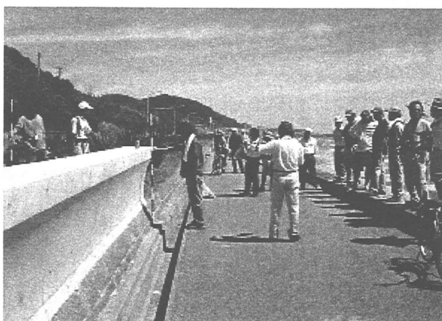
写真-1 実施された1次対策工
