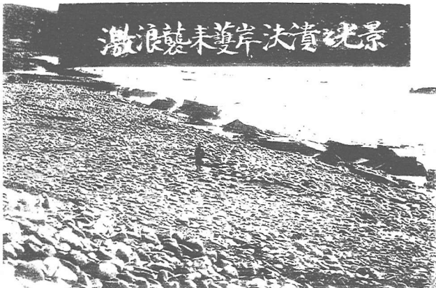
写真-8 激浪襲来護岸決潰之光景(大正時代中頃)
