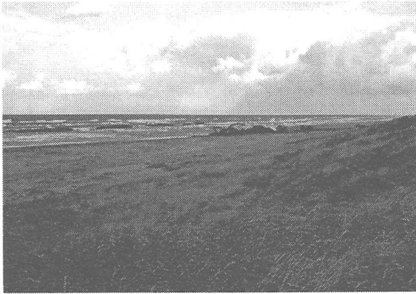
写真-9 巻漁港の東側隣接区域に設置された離岸堤背後の砂採取現場。
