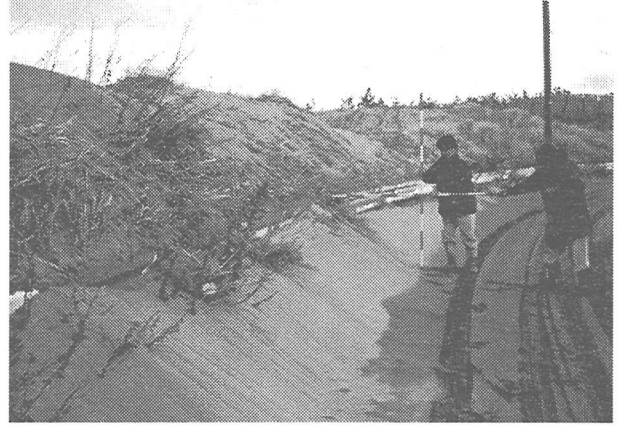
写真-15 飛砂防止フェンスの端部から道路に運ばれて堆積した大量の飛砂
