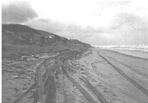
写真-4 緩傾斜護岸の西側隣接域の海浜状況
