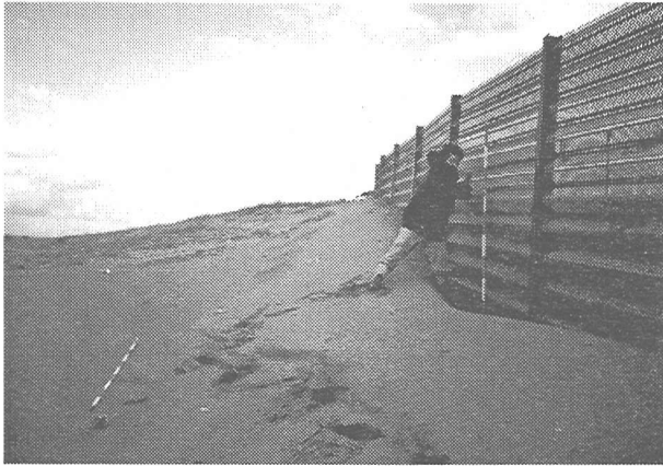
写真-13 巻漁港への道路の飛砂防止フェンスの外側での飛砂の堆積状況
