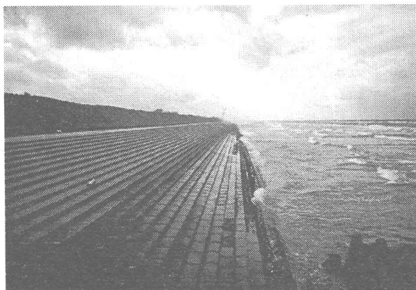
写真 - 2 新川漁港西側の直立護岸区域のさらに西側に延びる緩傾斜護岸
