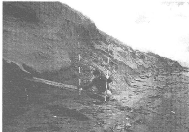
写真-6 基部の侵食により崩落した直後の浜崖
