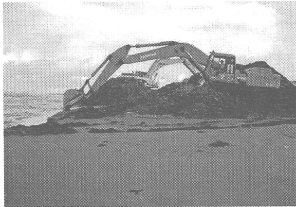
写真-10 汀線砂の掘削状況
