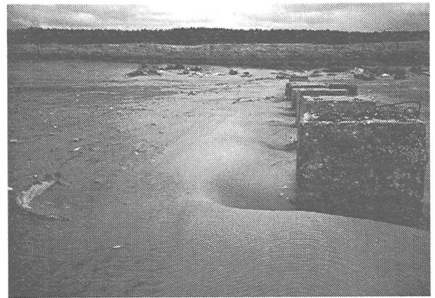
写真-12 巻漁港の漁港内とその外側を分けるコンクリート方塊の周囲に形成された局所洗掘孔
