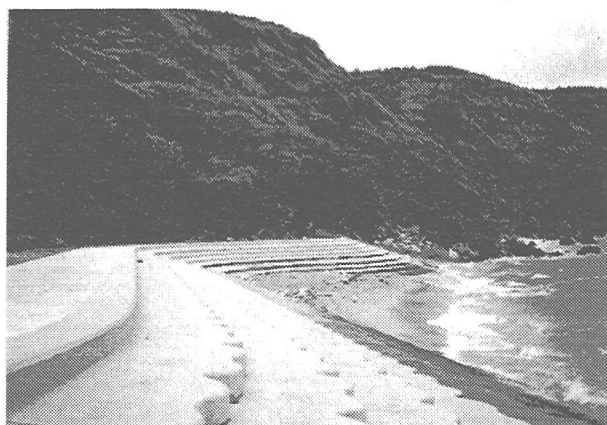
写真-9 護岸の隅に残された三角形の砂浜
