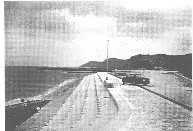
写真-5 写真-4の右端に見えるポールを中心として南側を撮影
