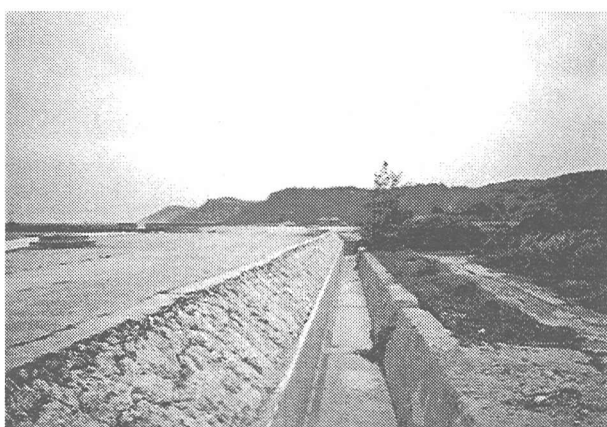
写真-10 浦底海岸での埋め立て以前の旧護岸（排水路の陸側の壁）
