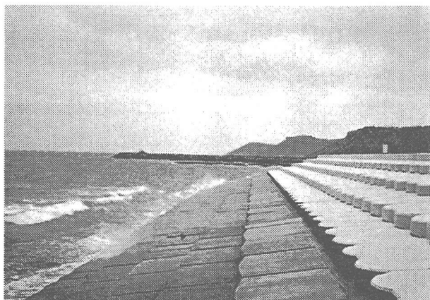
写真-6 のり先が海中に突出した緩傾斜護岸
