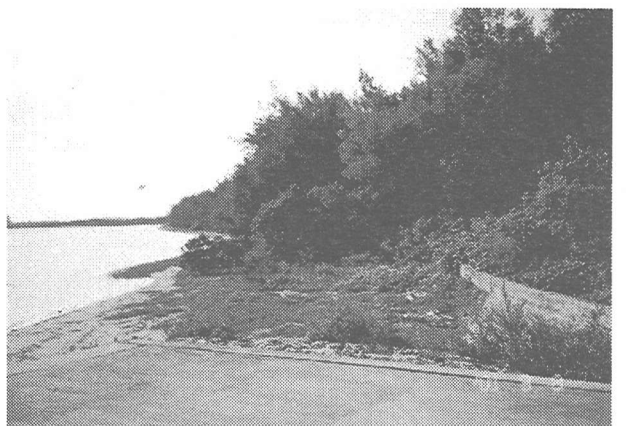
写真-20 緩傾斜堤の南端から南側の直立護岸とその前面の植生帯を望む
