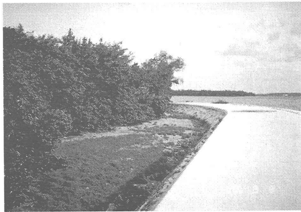
写真-13 植生帯と海浜上に造られた緩傾斜堤防
