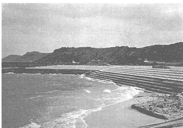
写真-7 緩傾斜護岸の隅に形成された狭い砂浜
