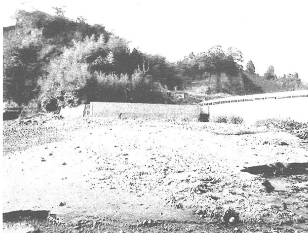
写真-4 尾本臨海港湾道路護岸
