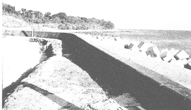
写真-3 美濃崎護岸工事現場
