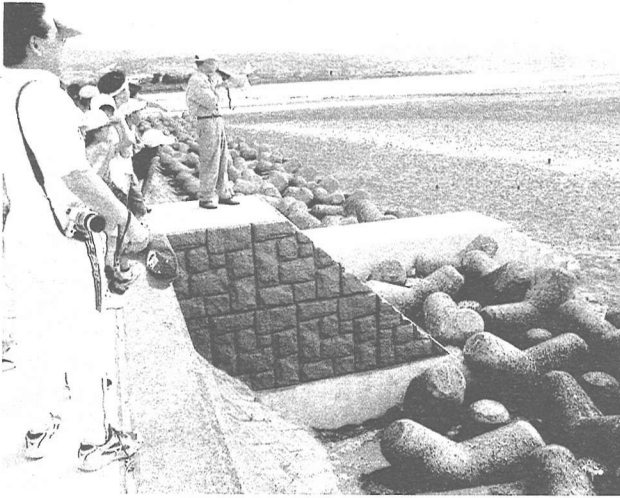
写真-5 八坂川河口階段
