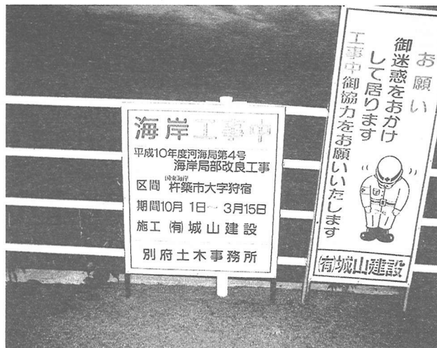
写真-2 美濃崎海岸工事中立て看板
