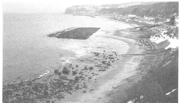
写真-7 低天端幅広消波堤完成写真
