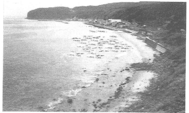
写真-5 緩傾斜護岸撤去後イメージ
