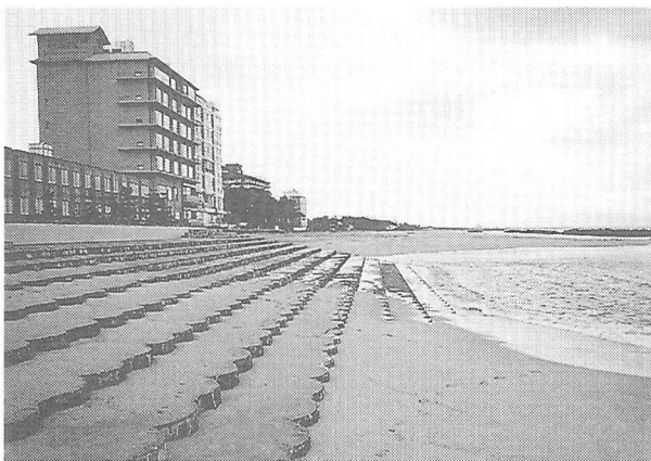
写真-1 1, 2号離岸堤の開口部の湾入汀線と そこに造られた緩傾斜護岸
