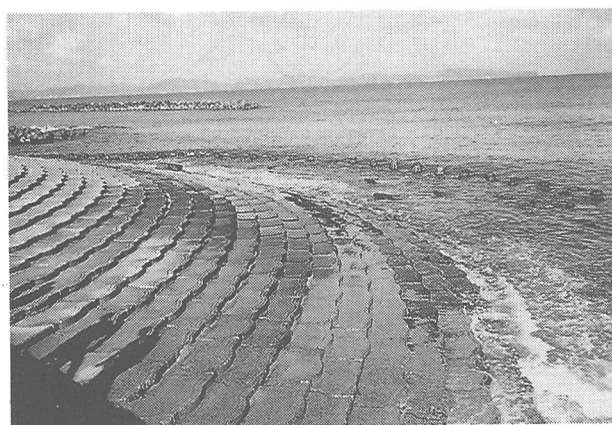
写真-6 写真-5の緩傾斜護岸を西向きに撮影
