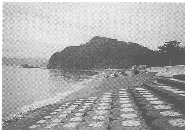
写真-11 写真-10に示す緩傾斜護岸ののり先部
