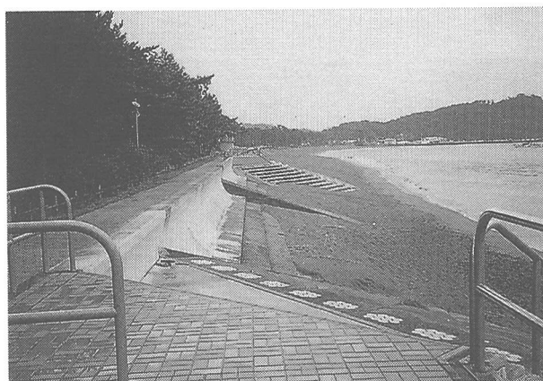
写真-8 環境整備事業によって建設された緩傾斜護岸上部の展望台
