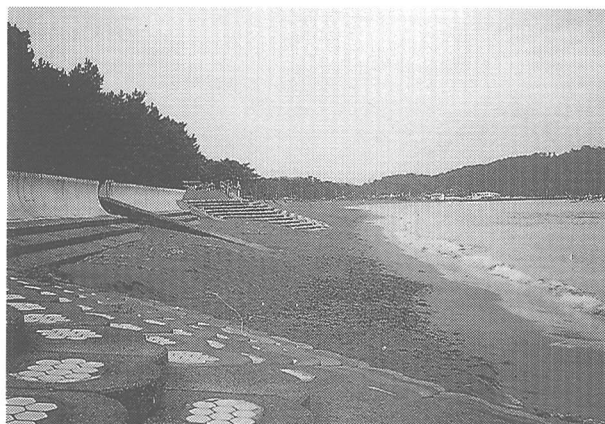
写真-9 写真-8に示す緩傾斜護岸ののり先部
