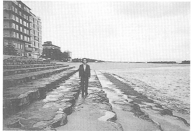
写真-2 緩傾斜護岸ののり先状況
