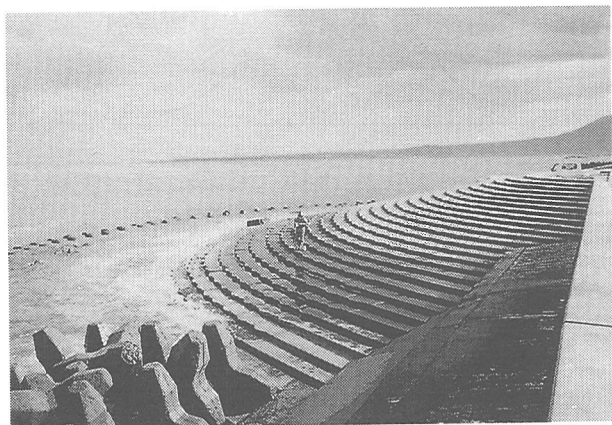
写真-5 離岸堤未設置区間に設置された緩傾斜護岸
