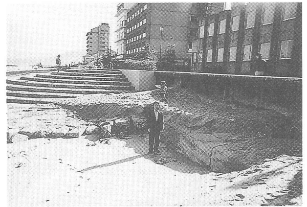
写真-3 緩傾斜護岸の西端部
