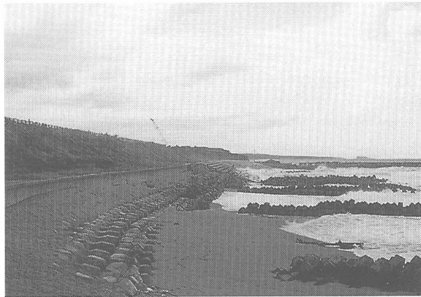
写真-8 大聖寺川河口の北東側隣接部の海岸状況
