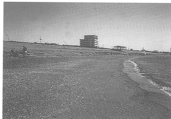
写真-6 侵食・堆積域の境界付近の海浜状況
