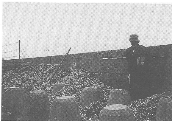
写真-9 直立護岸に残された盛土の高さ
