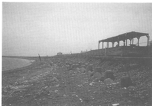
写真-12 小突堤背後の海浜状況
