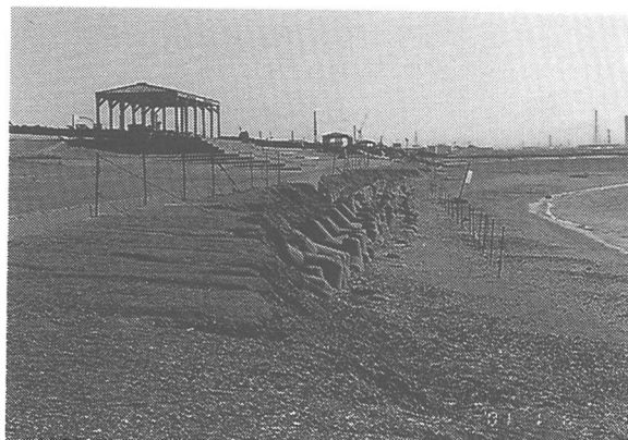
写真-7 侵食域の全体状況
