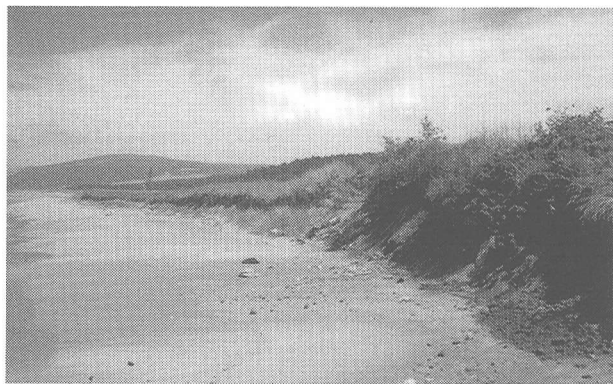
写真-14 緩傾斜護岸北東側端部の浜崖の形成状況
