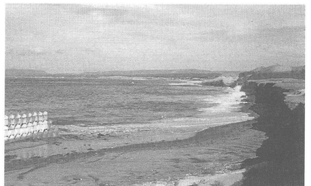
写真-6 裸地の東端近傍の離岸堤とその東側の浜崖
