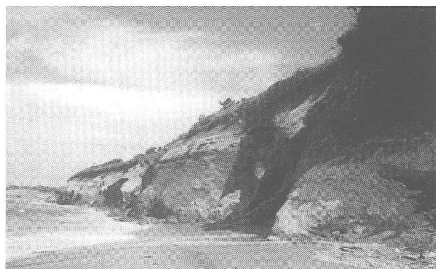
写真-11 石持漁港東側の海食崖の状況
