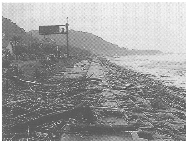
写真-2 越波直後の状況 (2000年7月8日撮影：台風3号)
