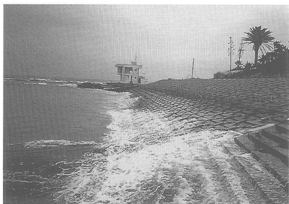
写真-1 瀬戸浜南部の緩傾斜護岸への波の遡上状況
