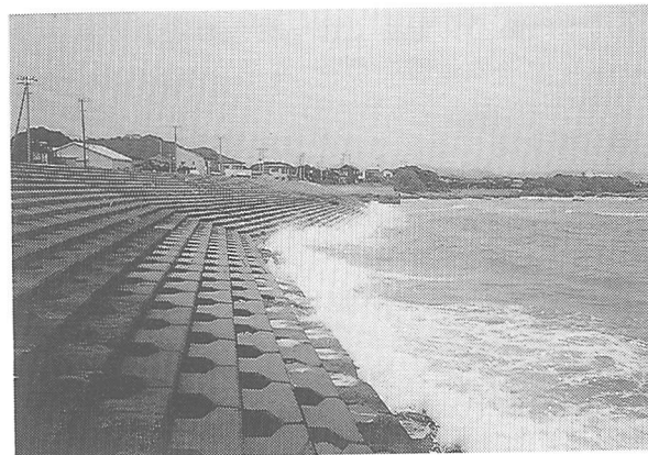
写真-7 緩傾斜護岸の表のり面での砕波状況
