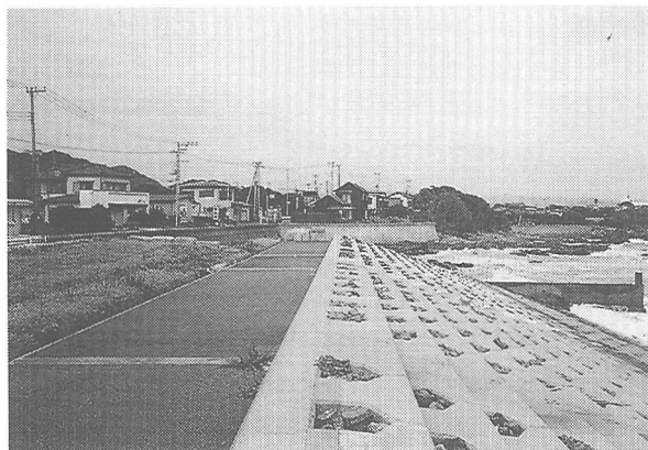
写真-4 前出しされた土地の海側を覆う緩傾斜護岸
