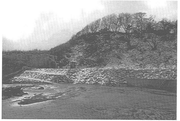
写真-2 赤川の護岸工
