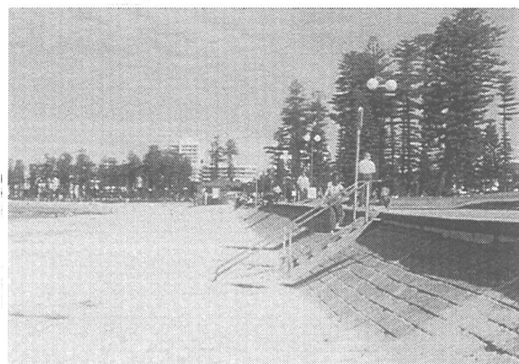
写真-14 Queenscliffビーチの海岸護岸と階段
