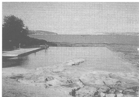
写真-3 Fairlight地区のポケットビーチの端部に建設された海水プール
