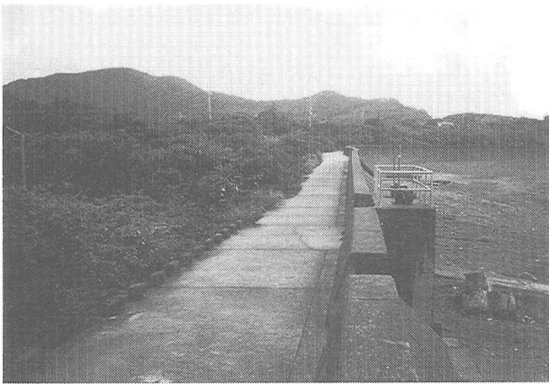
写真-6 樋管付近の海岸堤防と背後地の状況
