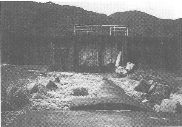
写真-5 海岸堤防を抜けて突出している樋管上から内陸部を撮影
