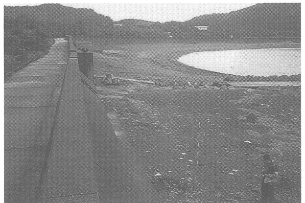
写真-3 樋門導流堤の東側に広がる三角形の海浜
