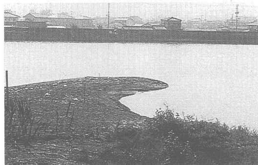
写真-5 左岸砂州先端部の状況
