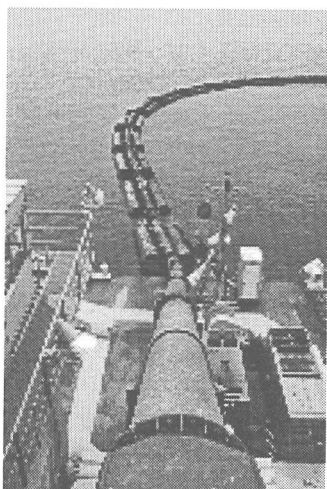
写真-2 海上配管
