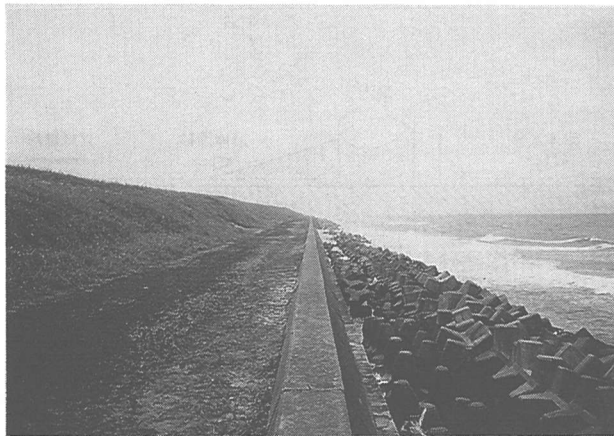
写真 - 6 直線的に延びた直立護岸とその前面の消波工
