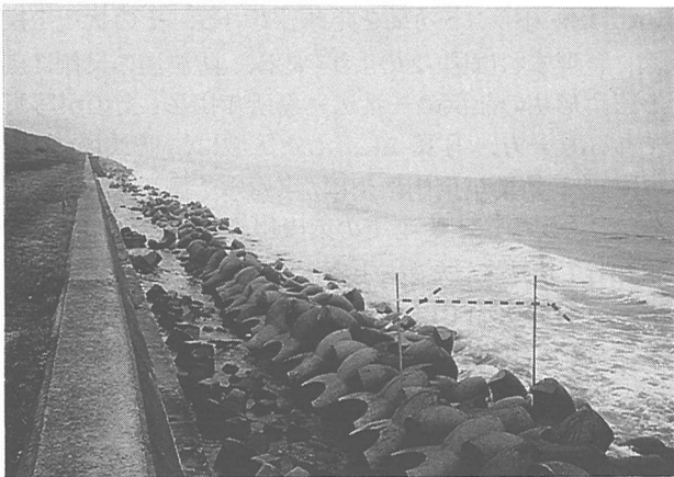
写真 - 7 消波工の災害復旧（嵩上げ）区間の基点
