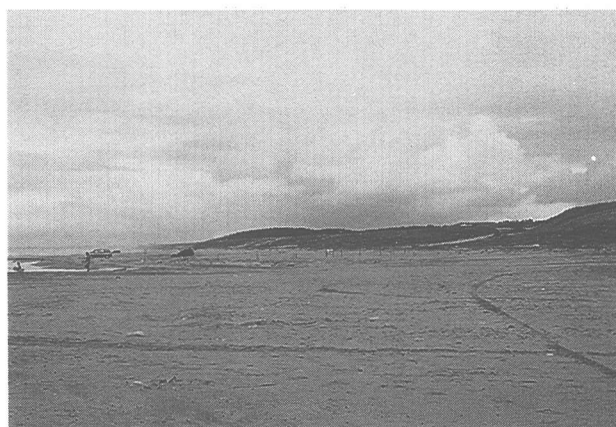
写真-4 新川漁港の防波堤の東側における堆砂状況
