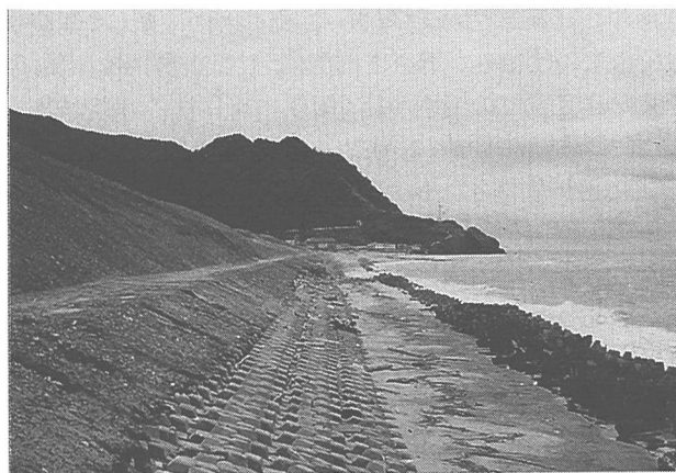
写真-14 巻漁港から角田岬方面に連なる護岸と消波工
