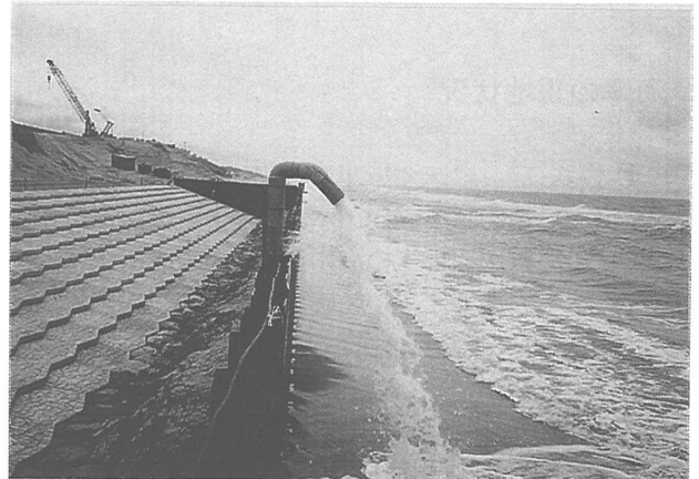
写真 - 10 災害復旧工事として建設されつつある緩傾斜護岸
