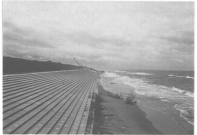
写真 - 8 直立護岸の西側に新設された緩傾斜護岸
