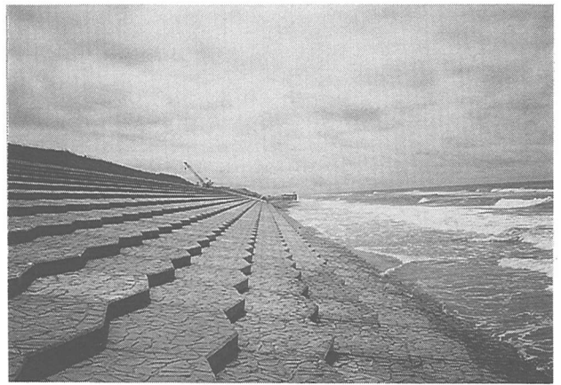
写真 - 9 緩傾斜護岸ののり先の状況
