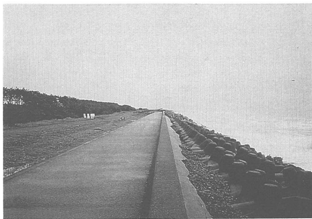
写真-11 駿河海岸川尻工区の海岸堤防と根固工
