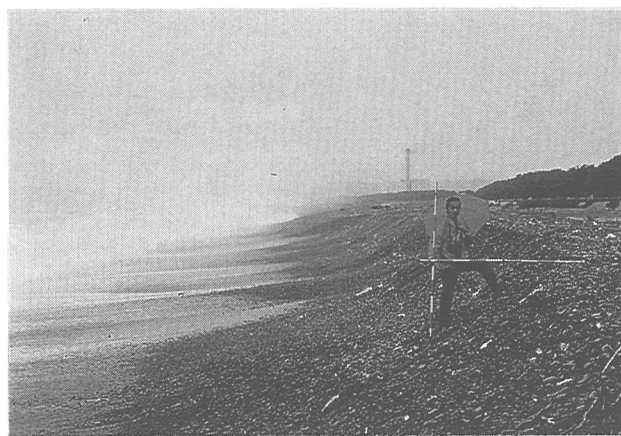
写真-18 侵食されて形成された浜崖
