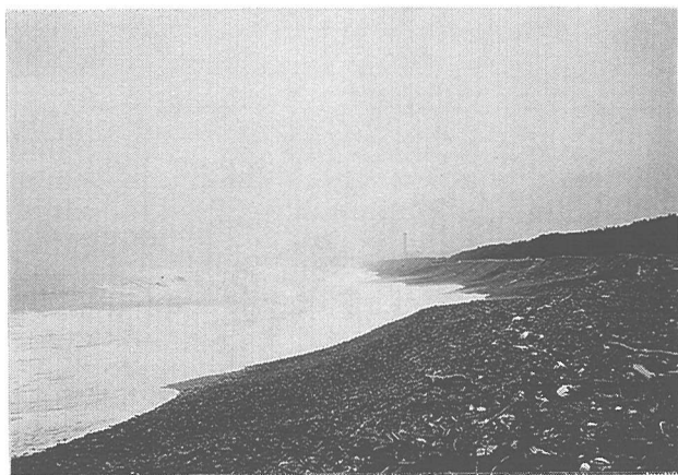
写真-17 消波堤南西側の汀線後退域
