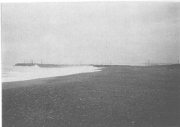
写真-10 吉田港の東側隣接域で砂礫が堆積して形成された広い前浜（1999年4月24日撮影）
