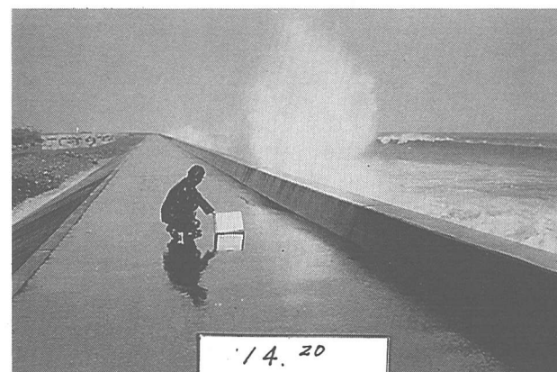
写真-4 海岸堤防への越波状況 (1972年10月31日 14:20)
