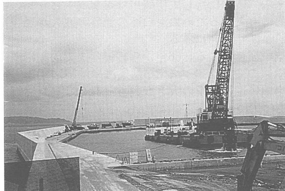
写真-14 鴨川フィッシャリーナ内での浚渫状況
