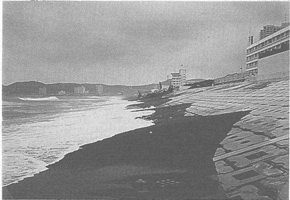
写真-7 緩傾斜堤の前面にごくわずかに残された前浜
