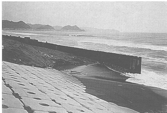
写真-6 新設護岸と護岸建設中の境界付近の海岸状況
