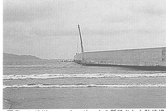
写真-13 鴨川フィッシャリーナの新設された防波堤
