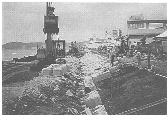
写真-5 鴨川シーワールド前面での護岸の災害復旧状況
