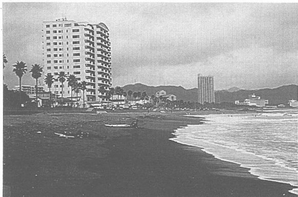
写真-11 前原海岸から北東方向の海岸線を望む
