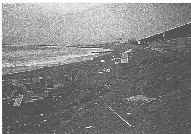
写真-2 4号突堤背後の水路跡を西向きに望む (1997年8月7日撮影)
