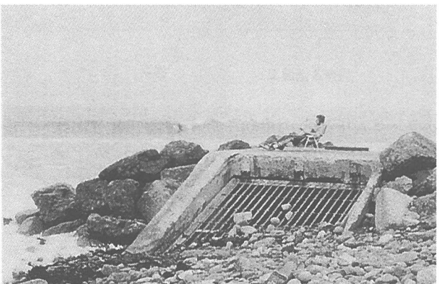
写真-14 海岸線に設置され、突堤効果を発揮している排水樋管
