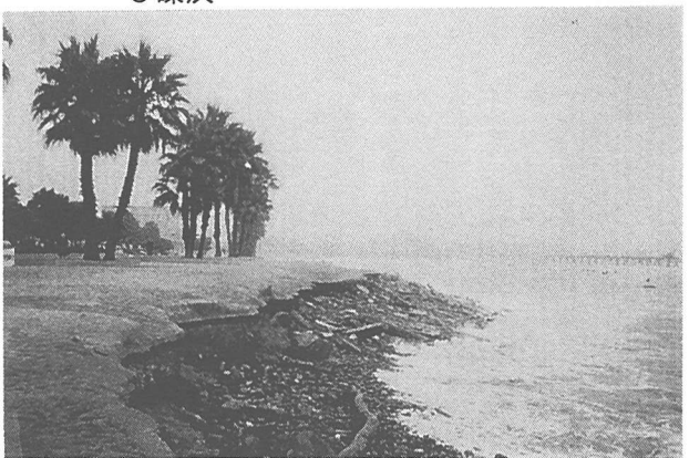
写真-12 侵食された人工地盤
