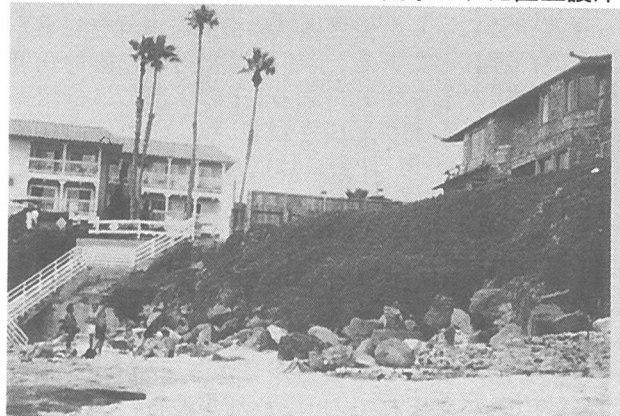
写真-10 砂浜背後の斜面を守るために設置された捨石
