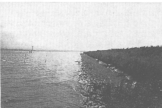
写真-3 樋門から東側を望んだ状況
