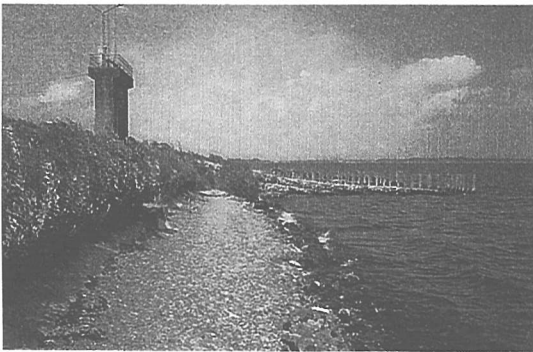
写真-1 樋門から東側端部の湖浜状況
