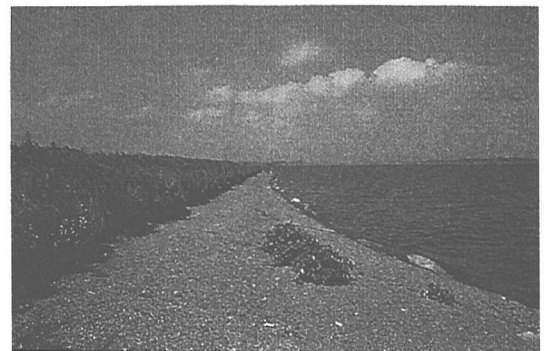
写真-5 東側端部付近の湖浜状況
