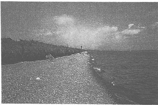
写真-2 樋門から西側を望んだ状況
