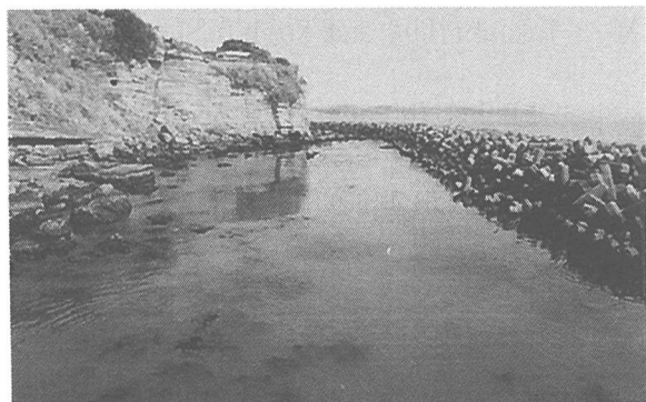
写真-2 小動岬の崩落現場と離岸堤間の水域状況 (1999年4月15日撮影)
