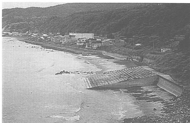
写真-3 木野部海岸北西部にある緩傾斜堤(1999年7月23日撮影)
