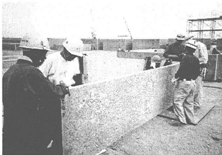
写真-2 RCプレキャスト埋設型枠組立状況
