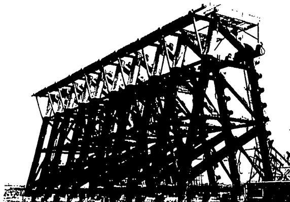
写真-1 傾斜板式防波堤 基礎構造部
