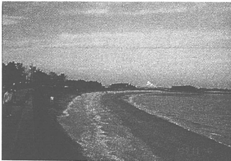
写真-4 海岸護岸の前面に海浜のみが広がる場所の海岸状況(写真-2の東側で撮影)
