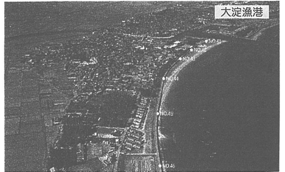
写真-7 大淀漁港の東側に延びた砂浜の空中写真 1)
