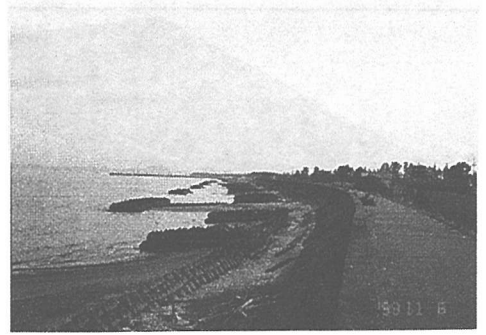
写真-6 前浜がほとんどなく消波工と護岸で守られた海岸の状況(写真-4の東側で撮影)
