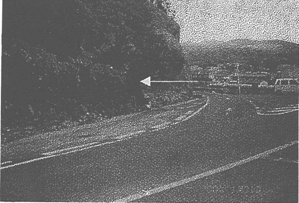
写真-4 和開橋西側付近の国道と崖上の痕跡 (矢印)
