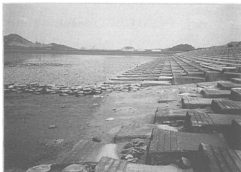
写真-8 南側の土嚢突堤周辺の海浜状況(1998年7月8日)
