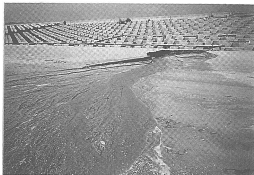
写真-7 カブトガニの産卵促進のための淡水供給状況
