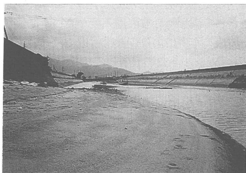
写真-12 河口砂州の上流端付近に形成された急斜面
