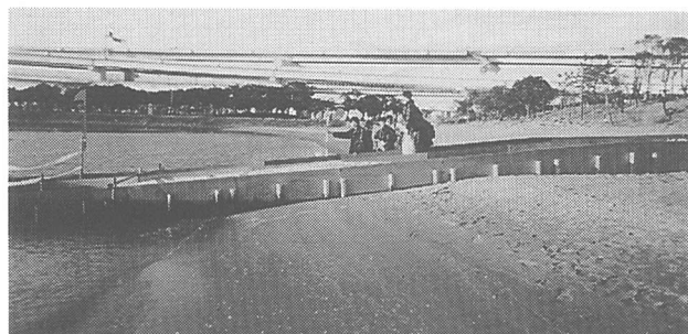
写真-3 板柵の設置状況
