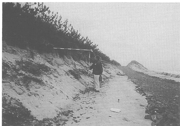
写真-10 決壊した海岸堤防背面の松林の被災状況
