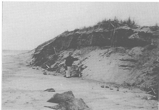
写真-9 決壊した海岸堤防の断面
