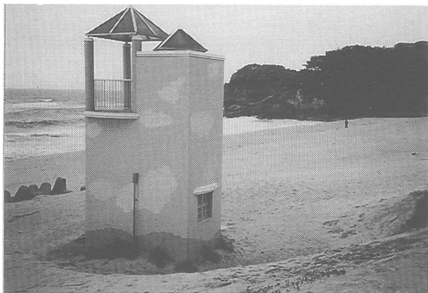
写真-5 伊師浜海岸の展望台周辺の洗掘状況
