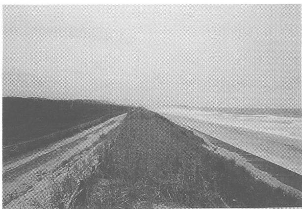
写真-7 海岸防災林を防護するための海岸堤防（土堤）
