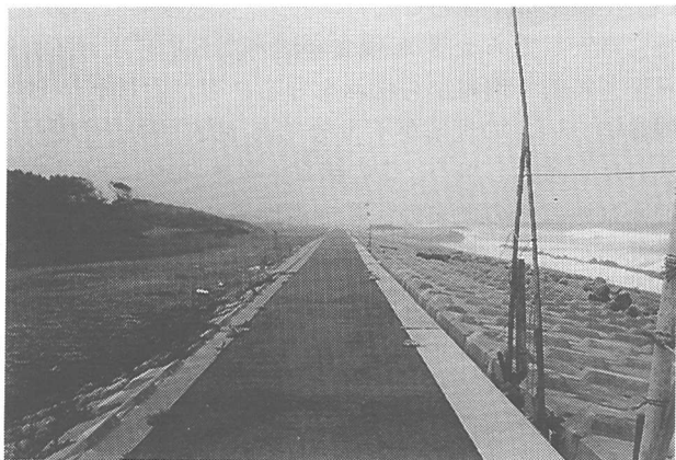
写真-15 緩傾斜堤の天端と背後地の状況
