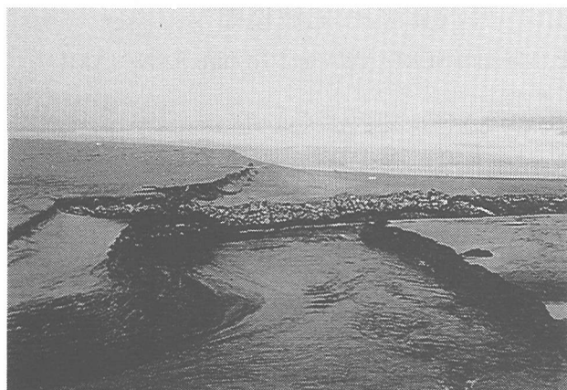
写真-2 三沢漁港の南約2.5kmに流入するA川の河口と蛇かご製の河口導流堤
