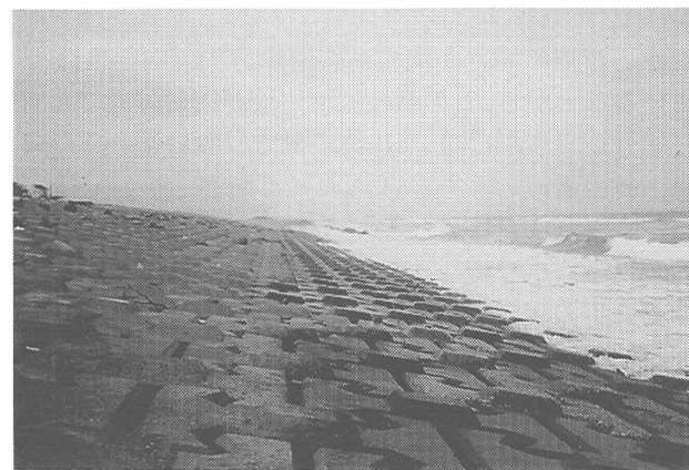
写真-14 侵食域で造られた1/4勾配の緩傾斜堤
