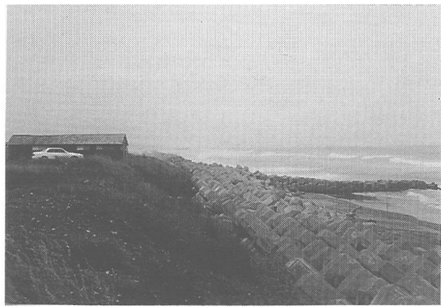
写真-12 三沢漁港の北側隣接部の突堤と消波堤によって守られた海岸線
