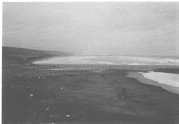
写真-17 三沢漁港の北部に建設されたヘッドランドとその周辺の海浜状況
