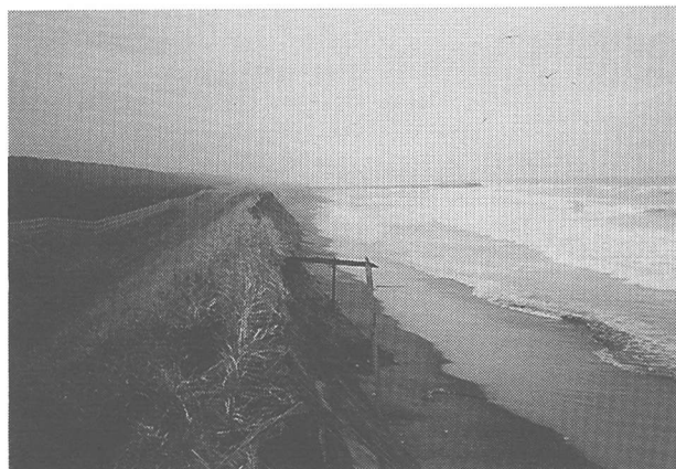
写真-21 最も高い浜崖の形成された海岸堤防（土堤）の上部（北向きに遠望）
