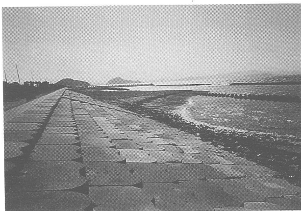
写真-14 緩傾斜堤上から南西方向を望む
