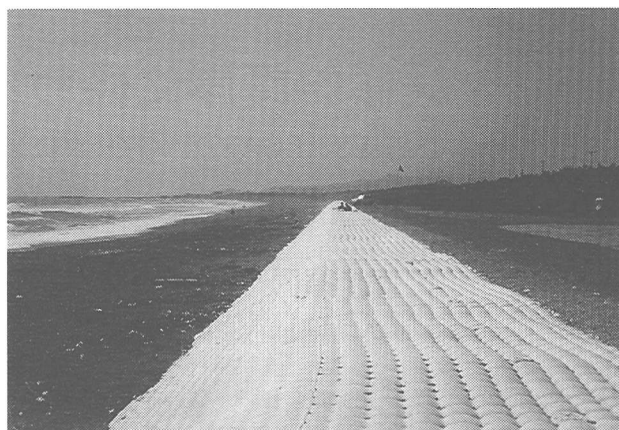
写真-4 コンクリートマット製の緩傾斜護岸 (千葉県大原海岸; 1998年9月13日撮影)
