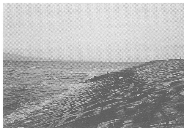
写真-3 緩傾斜護岸の例2
