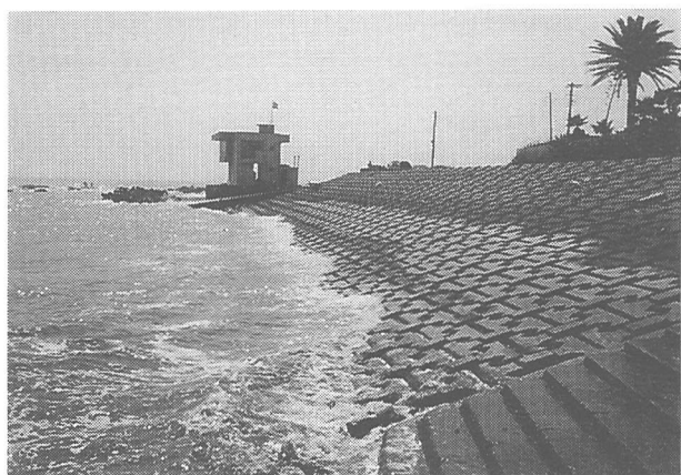
写真-6 緩傾斜護岸の例 2
