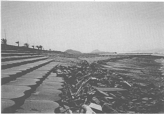
写真-15 露出した緩傾斜堤の根固め（南西方向）
