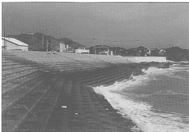
写真-5 緩傾斜護岸の例 1
