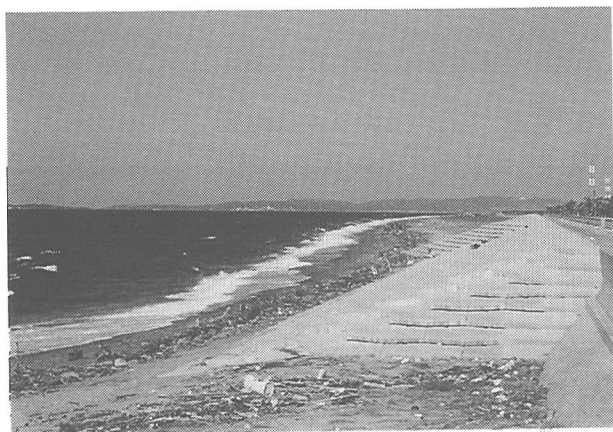
写真-10 写真-9と逆方向の北東を望んだ海岸状況
