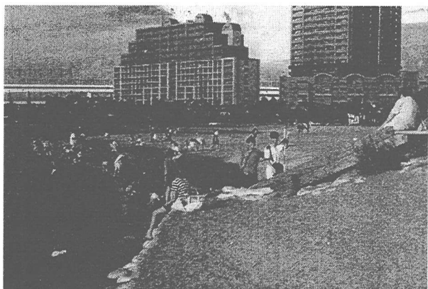
写真-15 木杭列の北東端部とそれより北東側の海浜状況
