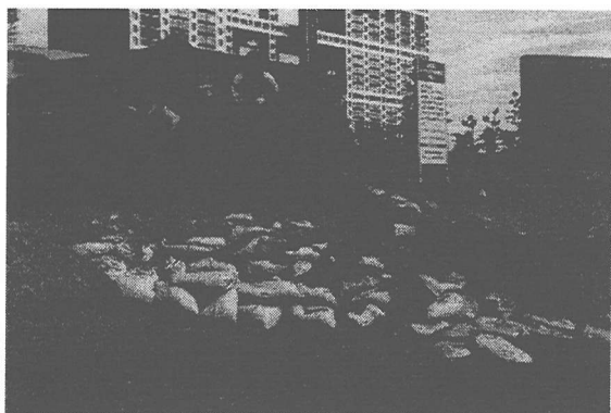
写真-7 木杭列による防護区間北東端に積み上げられた土嚢
