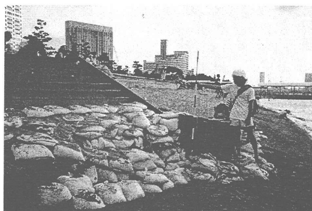
写真-16 木杭列端部の土嚢による防護状況
