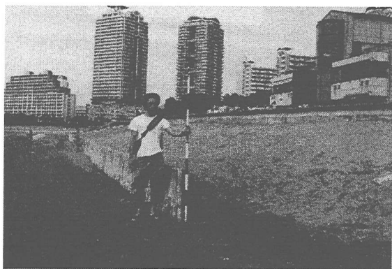
写真-6 侵食された木杭列の南西端部
