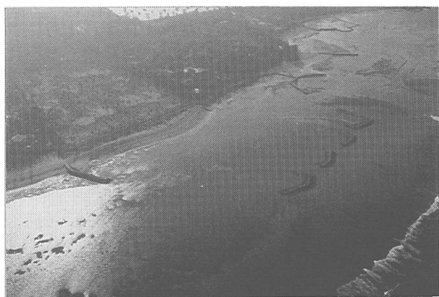
写真-10 Nusa Dua海岸南部のリーフフラット上に建設された4基の離岸堤群
