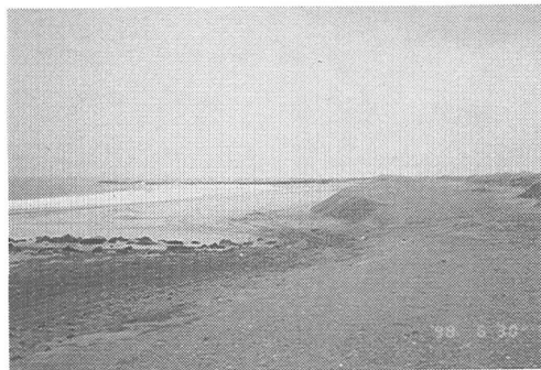
写真-10 バーム養浜工
