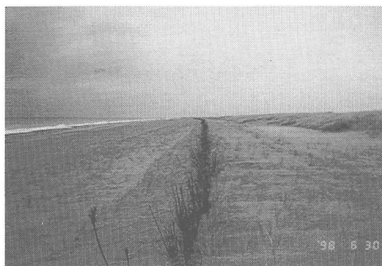
写真-9 アスファルトを用いた強化土堤
