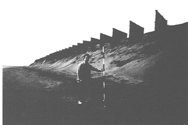
写真-13 侵食区域を西側向きに撮影
