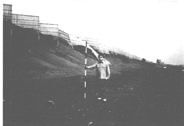
写真-11 4号水路まで連続的に延びた低位の浜崖
