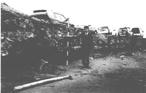
写真-14 管理用道路を切り込んで形成された約1.7mの浜崖
