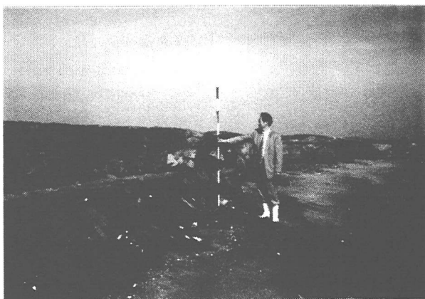
写真-7 一宮川左岸導流堤近傍の浜崖侵食
