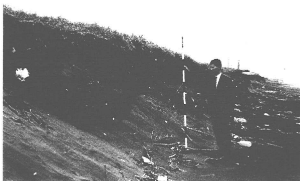
写真-16 浜崖侵食と植生状況
