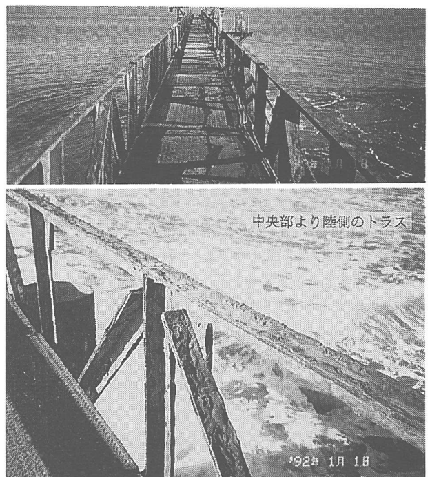
写真-2 栈橋の上部鋼材トラス工の状況
