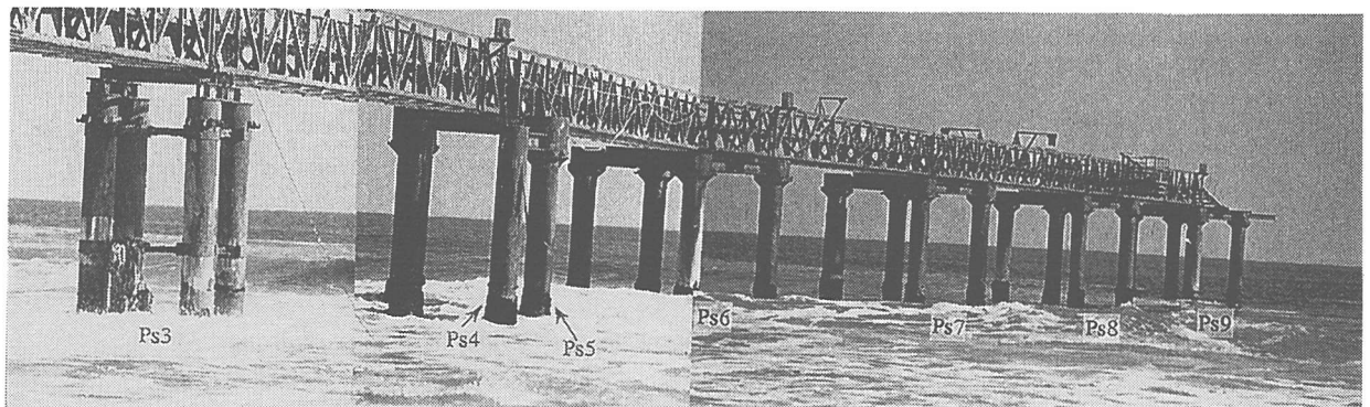
写真-1 栈橋の基礎工の鋼管杭の状況
