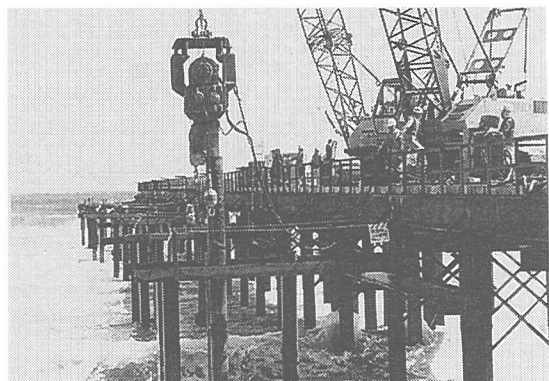
写真-4 鋼管杭引き抜き状況
