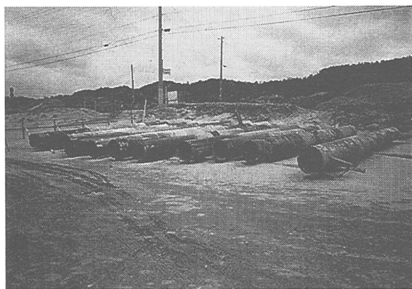
写真-5 引き抜き後の鋼管杭
