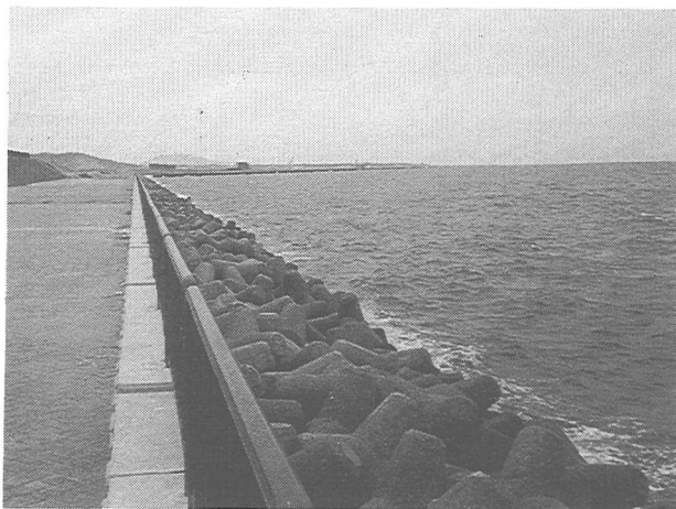
写真-5 人工海岸（垂直岸壁+消波ブロック）
