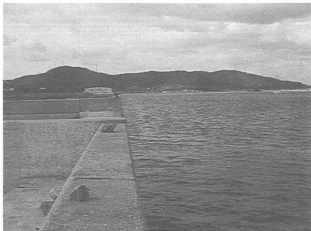
写真-4 人工海岸（垂直岸壁）
