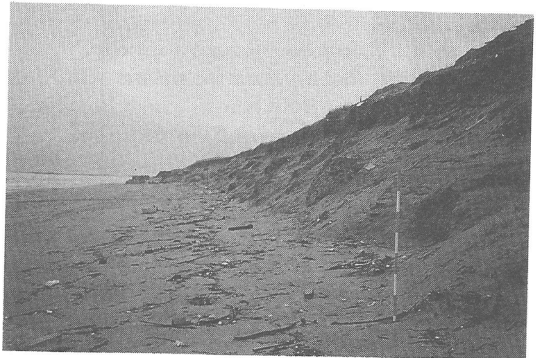
写真-3 新川漁港南側の浜崖形成状況(1996年6月26日撮影)
