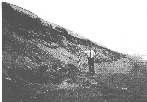
写真-4 柳島地先の消波堤の東側隣接域に形成された高さ約3mの浜崖 (1997年8月7日撮影)
