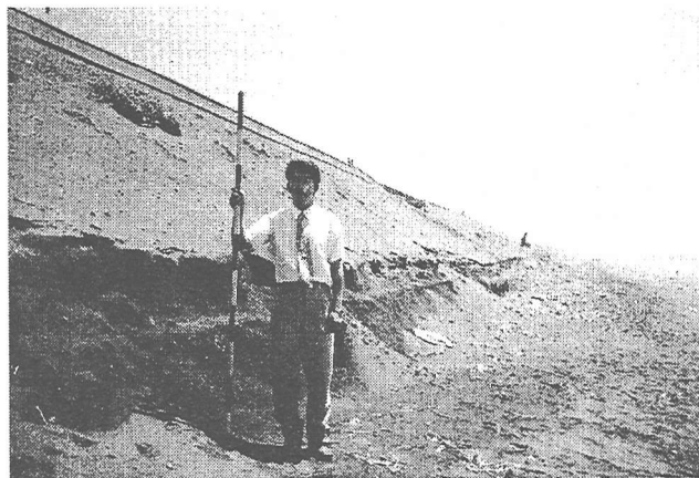
写真-3 写真-2よりわずかに東側における浜崖の状況 (1997年7月3日撮影)
