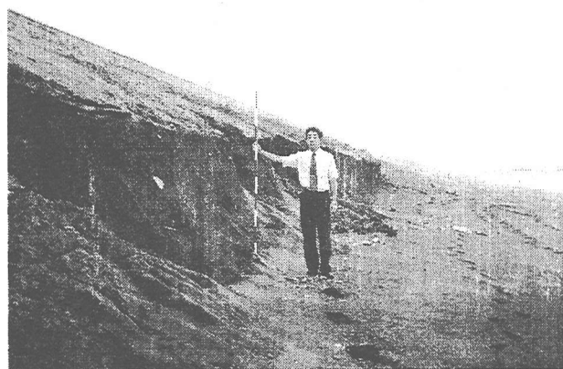
写真-6 写真-5の東側における浜崖形成状況 (1997年8月7日撮影)
