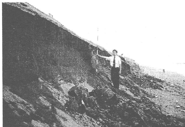
写真-5 写真-4のさらに東側地区における浜崖形成状況 (1997年8月7日撮影)
