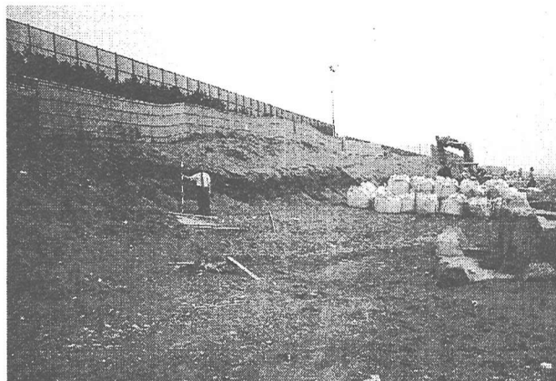
写真-14 侵食により形成された4号突堤背後の水路跡（1997年8月7日撮影）
