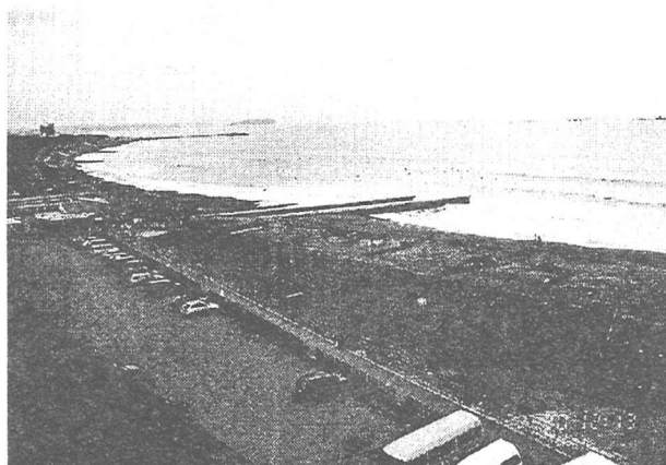
写真-7 茅ヶ崎漁港の東側隣接部の海岸状況。 中央部にあるのは6号水路
