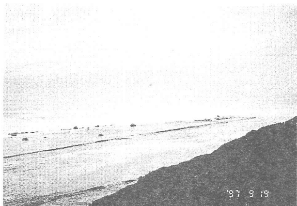
写真-3 柳島の斜路の西側の消波堤背後での西向き流れの発達（9月19日撮影）
