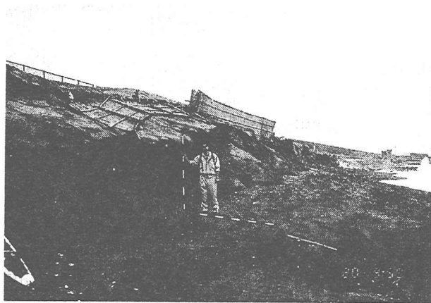
写真-11 写真-10の東側隣接部における浜崖形成状況
