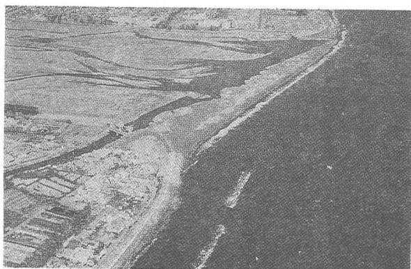
写真-2 広野海岸に隣接する安倍川河口の斜め写真 (1997年2月20日撮影)
