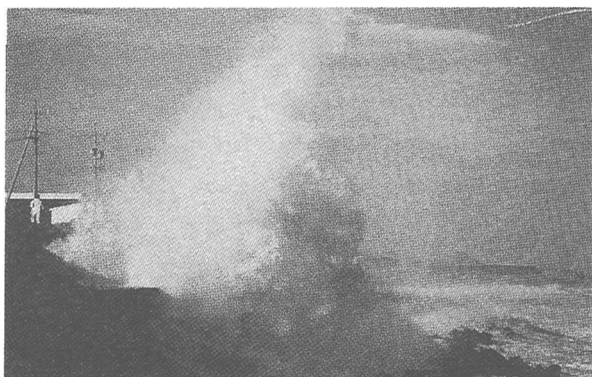
写真-3 No. 95 のすぐ南側に位置する静岡市の埋立護岸上から北側の護岸の越波状況（1997 年 6 月 20 日撮影）
