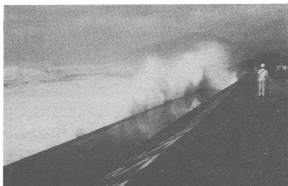
写真-6 No. 90, 91 地点の離岸堤開口部への越波状況（1997 年 9 月 3 日撮影）
