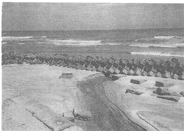
写真-4 消波堤の背後へと流れ下る 所沢川の流路
