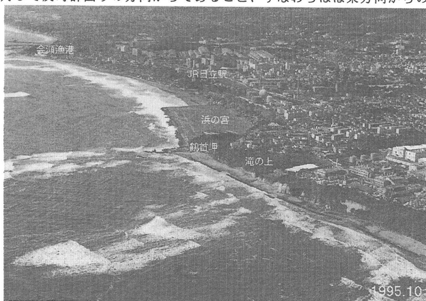
写真-2 浜の宮の埋立地を中心とする区域の斜め空中写真
