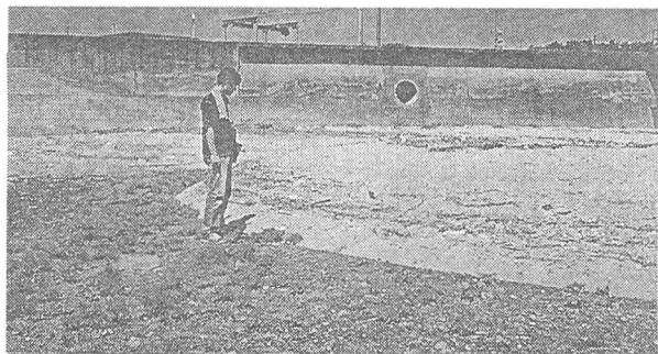
写真-4 中央の砂州の先端部に形成された急勾配斜面
