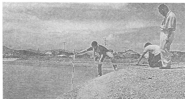
写真-6 河口砂州先端部の急勾配斜面
