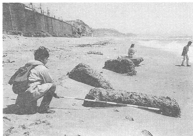
写真-10 海浜に散在するコンクリート塊周辺の海浜状況
