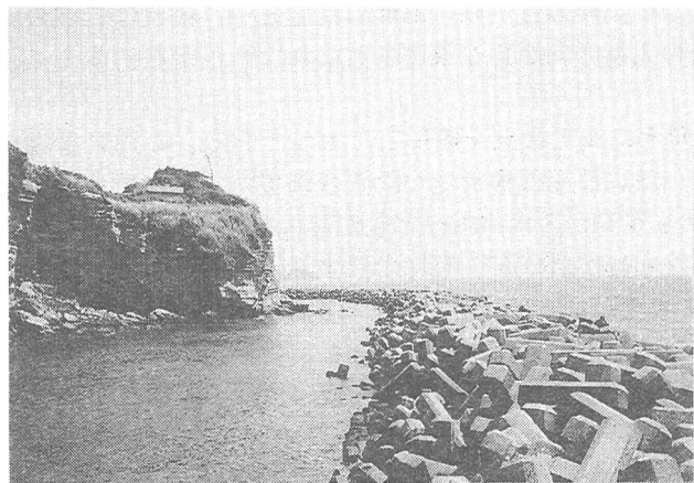
写真-7 小動岬の海食崖と侵食防止を目的とした連続離岸堤
