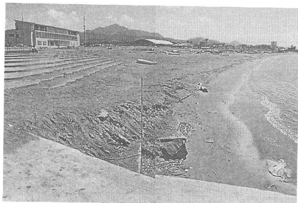
写真-5 A突堤基部よりB突堤方向を望む
